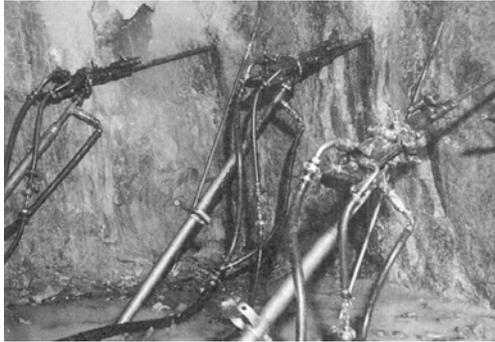
Fig. 1.4 Three drill hammers on airleg
