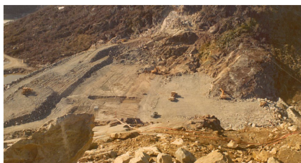
Figure 3.8.5. Overview of the Førsvatn rockfill dam, Kjela HEPP, Telemark Norway (J. Rohde 1976).
